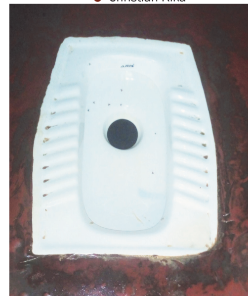
Vue d'une latrine au marché de Nguba
